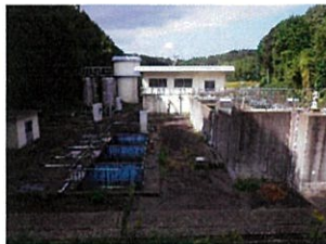
5.大山浄水場外観
