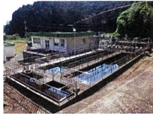
3.新西浄水場外観
