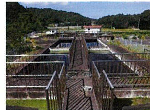
6.西崎浄水場外観
